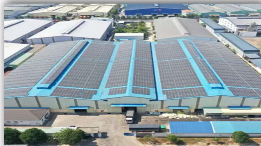
Phu Giao: 1.000 KWp
