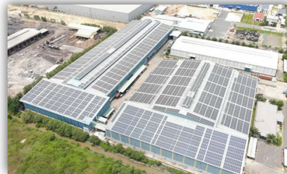
Công ty Nhật Hòa- TP Thủ Đức
